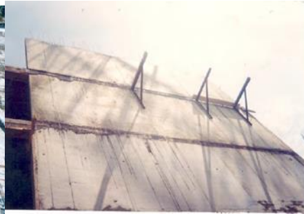
Figure 4 : Panneaux de façade de hauteur d'un étage
