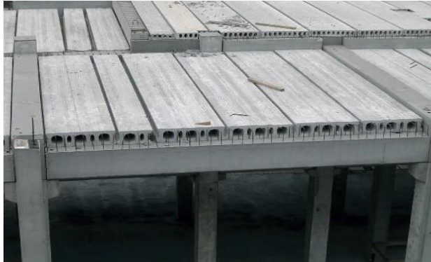
Figure 141 : Dalle en béton précontraint
