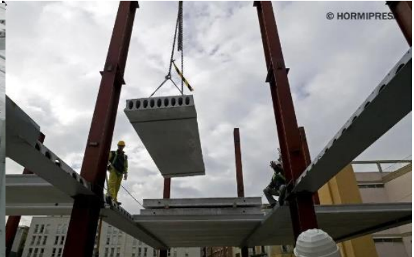
Figure 140 : Dalle en béton
