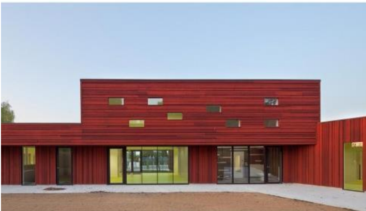
Figure 100 : La façade Sud- Ouest
