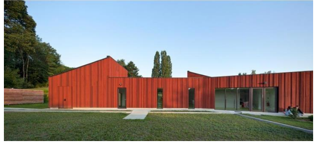
Figure 99 : La façade Sud-Est
