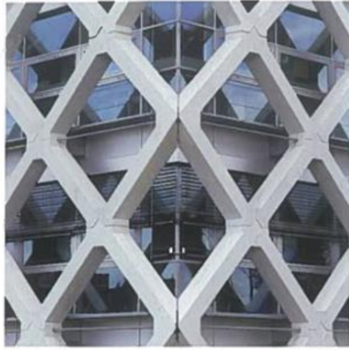
Figure 17 : Façade en treillis constituée d'un treillis d'éléments préfabriqués en béton. Eléments en béton préfabriqués, Wageningen (NL) 2006, Rafael Vinoy
