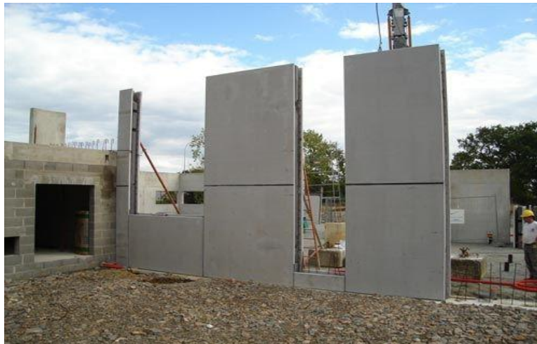
Figure 142 : DUO Mur (mur à coffrage intégré)
