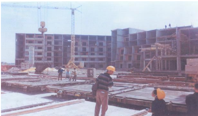
Figure 12 : Atelier précaire a l'air libre pied de l'ouvrage édifié
