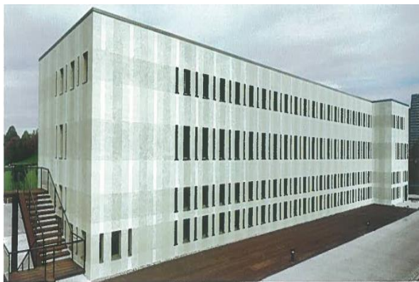
Figure 32 : centre de technologie Munich
