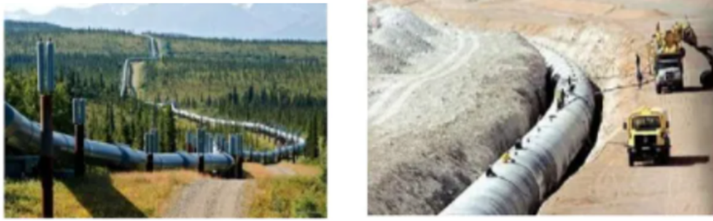
Figure 2.6 – Type de mode de pose de pipeline
