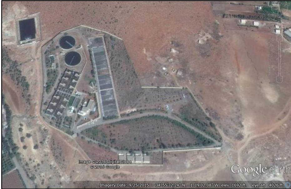
Figure 3 vue de la station d'épuration D'AIN EL HOUTZ
