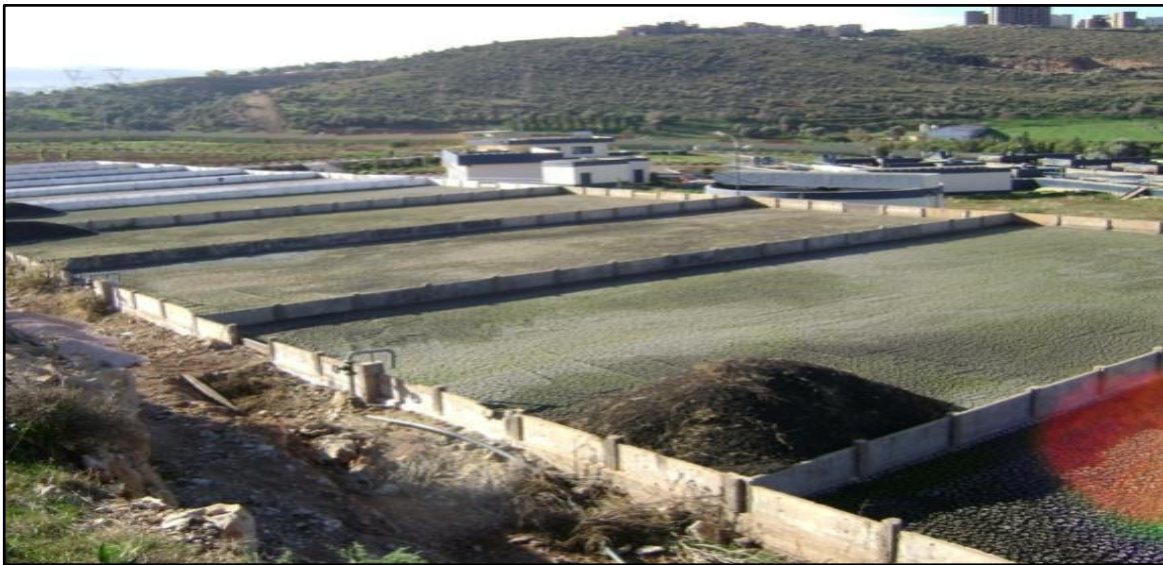
Figure 16 les lits de séchage.
