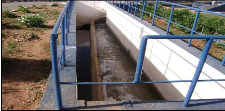
Figure 4 le déversoir de laSTEP D'AIN EL HOUTZ.
