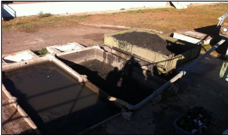
Figure 9 les bacs à sable
