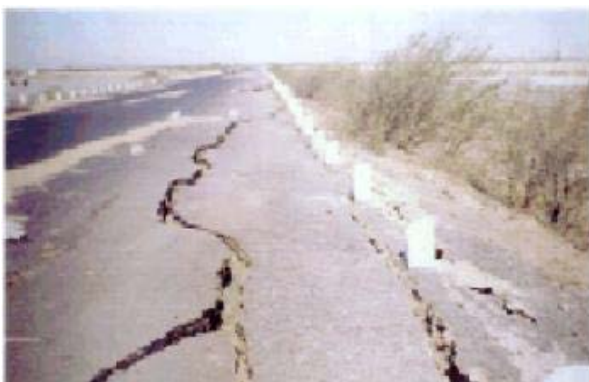
Figure 1. 7 Déplacement latéraux du terrain (Ali B, 2005)
