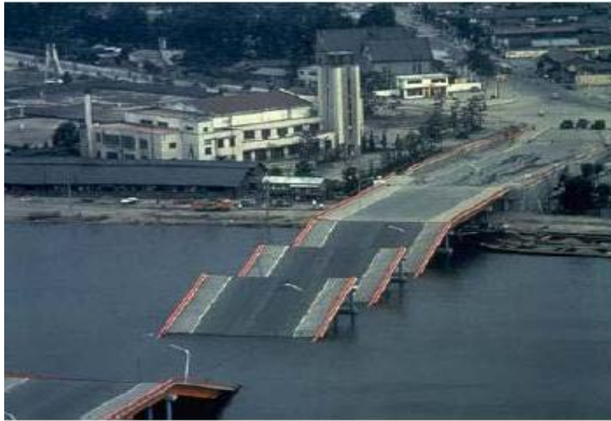
Figure 1. 5 Effondrement des tabliers (Juang, C. H, 2002)
