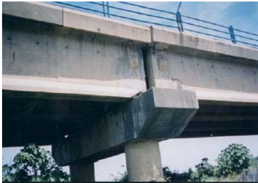
Figure 1. 6 Déplacement latéral et longitudinal (Ali B, 2005)
