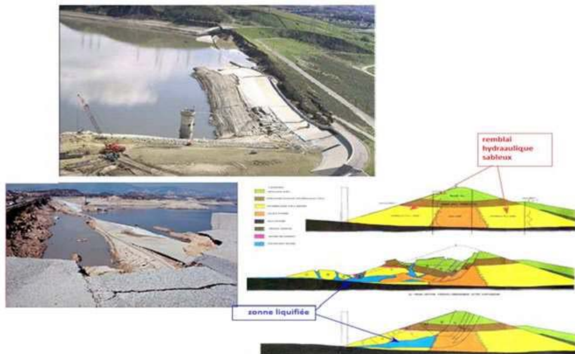
Figure 1. 3 Effondrement du parement amont du barrage de San Fernando pendant Le séisme de 1971
