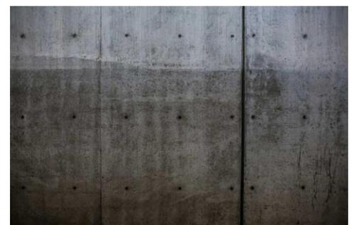
**Fig.151 :** Murs En Béton Banché
