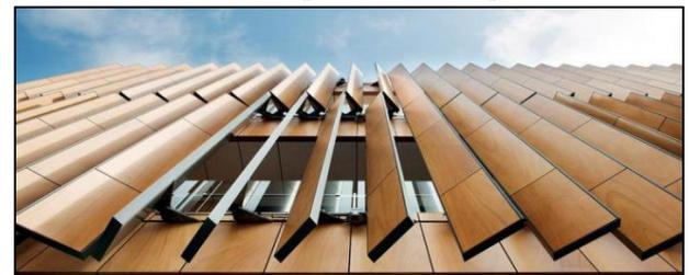
**Fig.183** : Les Brises Solaires À Lames Orientables
