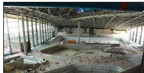
Fig. 75 :détaille d'intérieur de la structure
