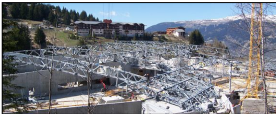
Fig.74 :La mise en place de la structure tridimensionnelle
