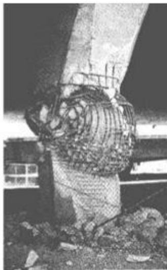
Figure 1 - 5 : Exemple de rotule plastique dans une pile de pont.
