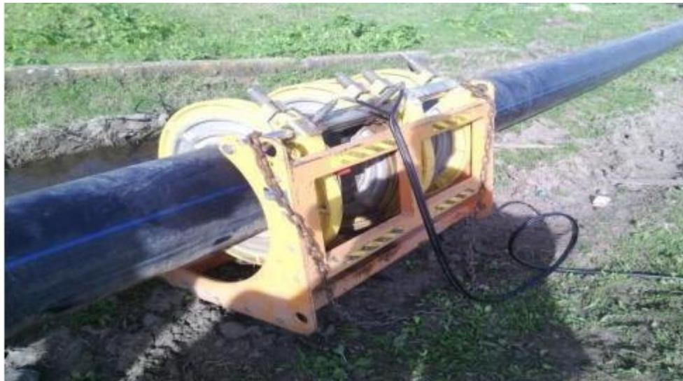
Figure I-19 : Machine à souder bout à bout [15]
