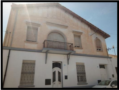
Bâti en bon état.
