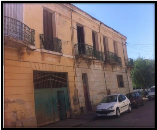
Figure 18 : Poste de sécurité 1940.
