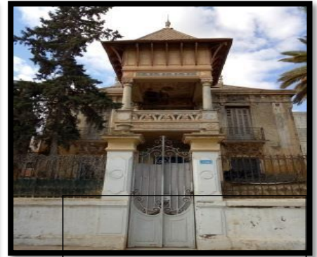
Bâti en état dégradé.
