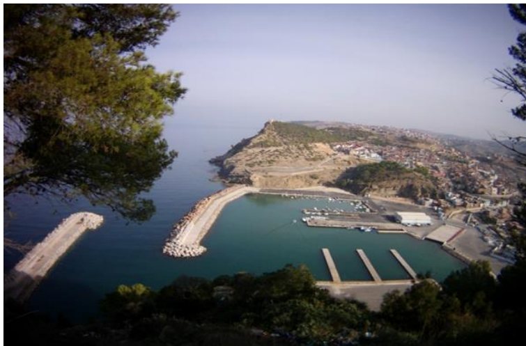
Figure 16 : Vue générale sur le port de Honaine(original)
