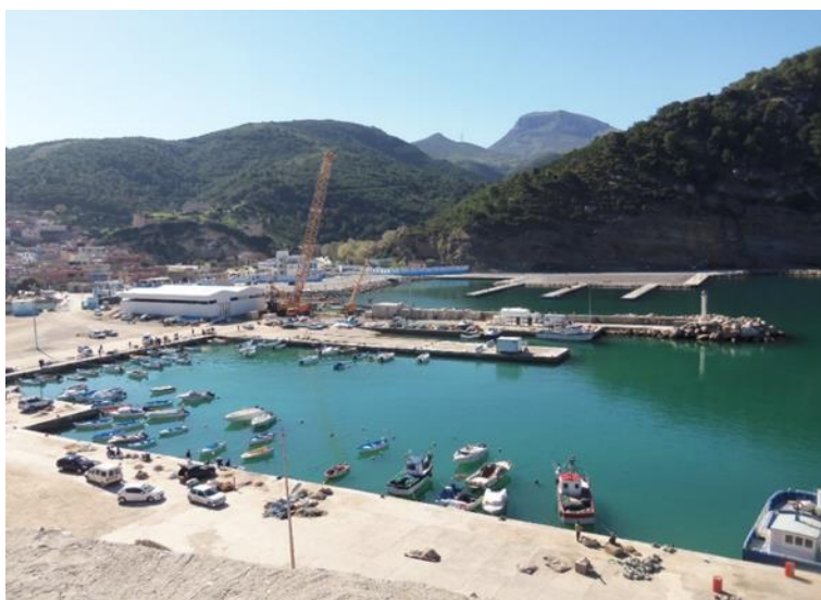
Figure 17 :Bassin d'accostage et structures d'appui(original)
