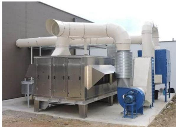
**Figure 178.** Centrale de traitement de l'air (CTA)
