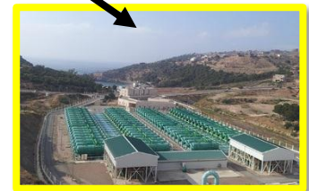
Figure 117 . Usine de dessalement de Teclém
