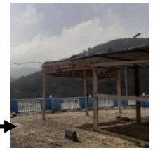
Figure 127 . Une ancienne pergola banc
