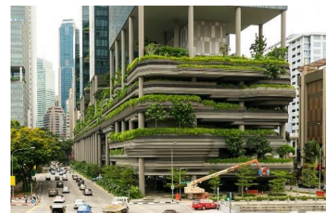
Figure 5. le bâtiment vert
