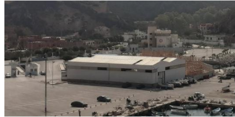
Figure 122 . Hangars des bateaux
