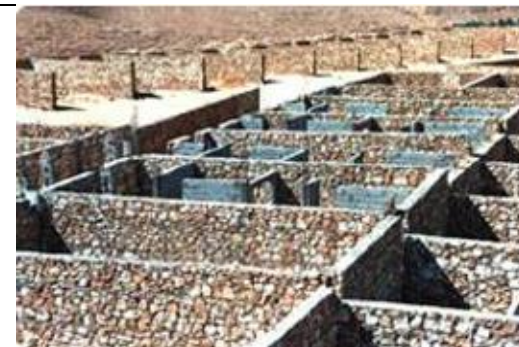
Figure 2-45 : Pierre dans la construction Source: http://tafilelt.com
