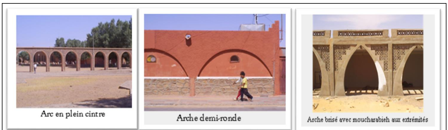
Figure 3-21: les arcades existant dans la commune de taghit source :auteur
