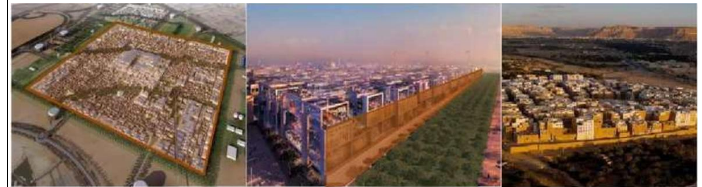
Figure 2-53: un mur extérieur Masdar City source : http://www.transsolar.com/fr/projects/abu-dhabi-masterplan-masdar-city
