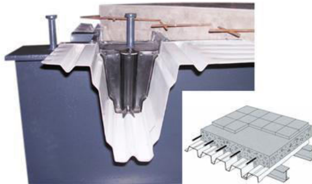
Figure 77: principe d'une construction collaborante.
