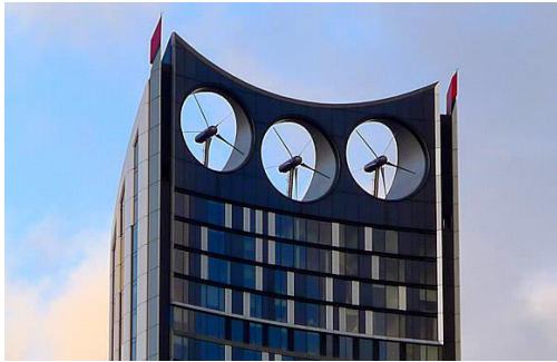
Figure 10: Eolienne à axe horizontale, Strata Tower
