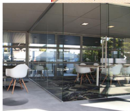
Cloison séparative vitrée
