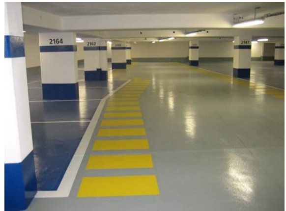
Figure 129 : Sol résine pour parking
