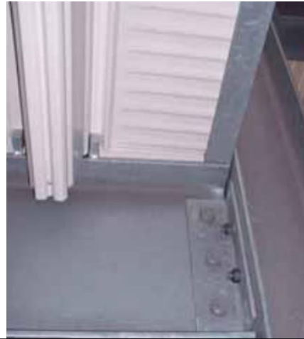
Figure 95 Positionnement des profils trapézoïdaux
