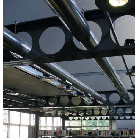
Figure 79: les gaines porté par poutre alvéolaire
