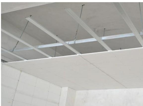
Figure 181 : faux plafond plaques de plâtre
