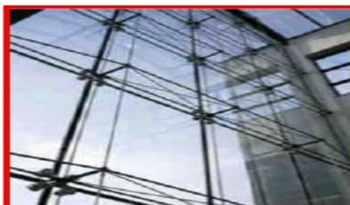
Figure 175 : Fixation par rotule
