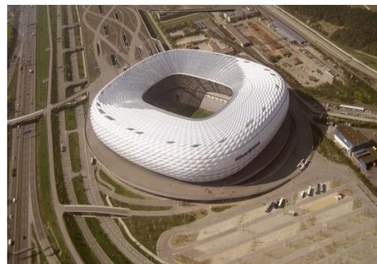
Figure 8:Le stade de Munich Structure gonflée par d'air sous pression
