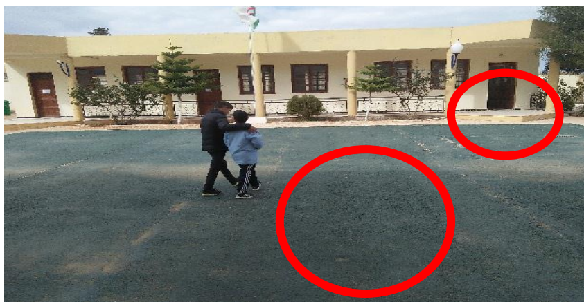
Figure 08. La cour centrale de l'école Source. prise de photo
