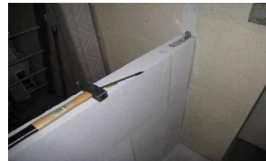
Figure 175. Mur en siporex Source. jardinetmaison.fr
