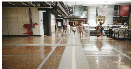
Figure 205. Bon repérage de cheminement vers les issues de secours. Source. Cfpsaa.fr
