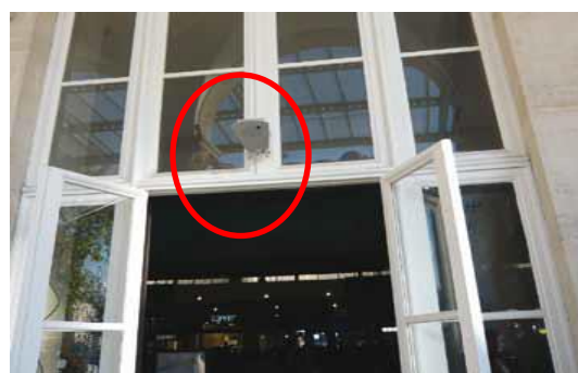
Figure 31. Balise sonore bien placée au-dessus d'une porte Source. cfpsaa.fr
