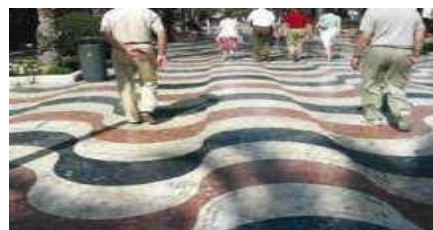
Figure 43. Revêtement à proscrire car les motifs créent une confusion.
