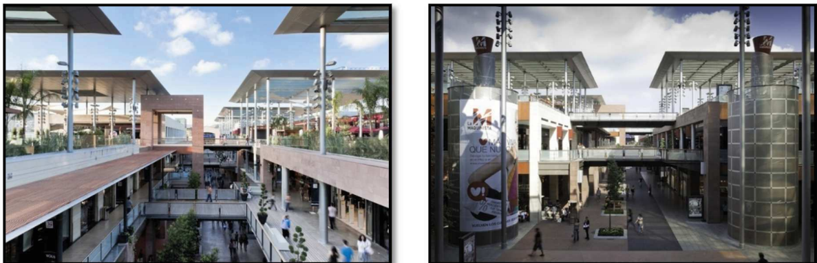
Figure 35: photos du centre commercial le machiniste
