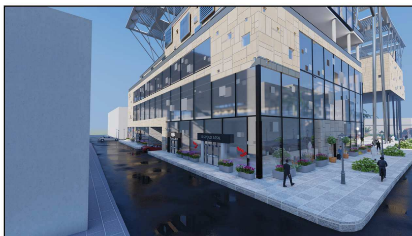
Vue depuis la rue Benchoura Yahia (voie sud )
