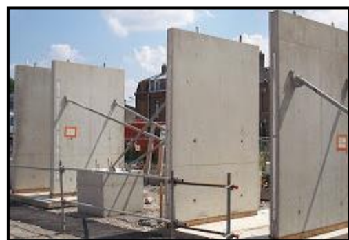
Figure 118. Voiles de contreventement
