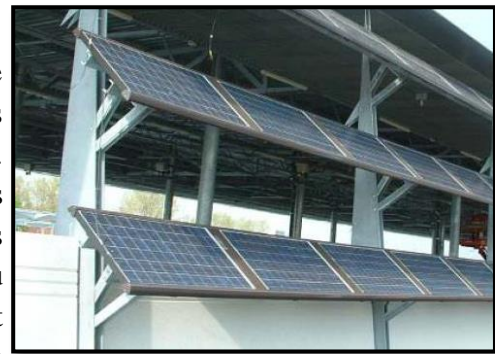
Figure 122. Exemple d'un brise soleil
