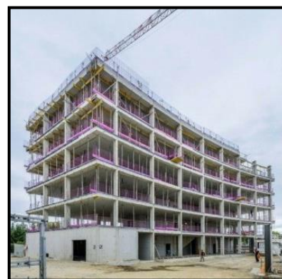
Figure 115. Structure en poteau-poutres
