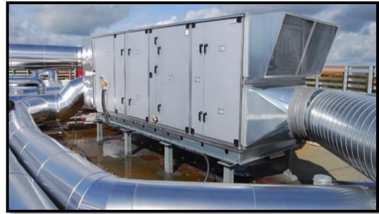
Figure 147. Exemple d'une CTA
