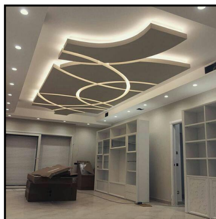
Figure 127. Exemple d'un faux plafond en placo plâtre
