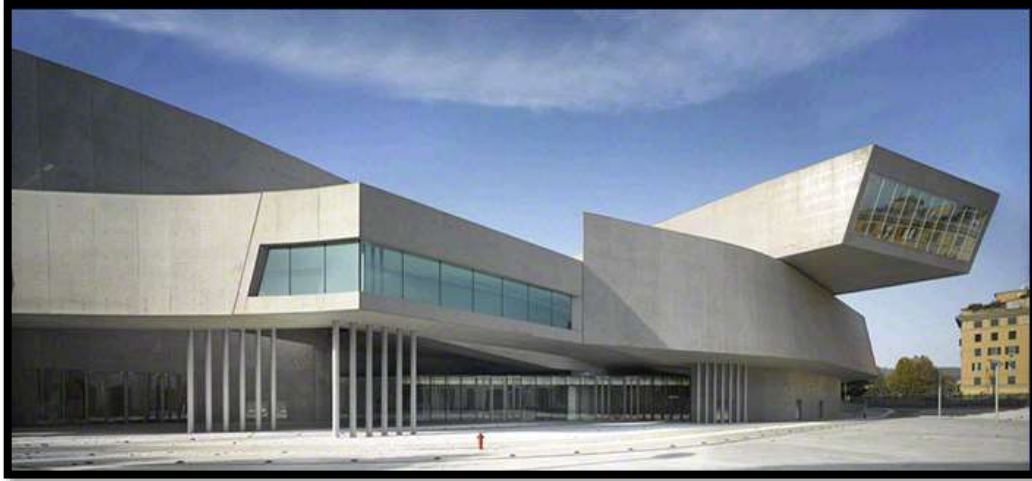
Figure 197 facade principale du musée facade en beton lisse
