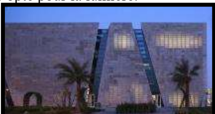
Figure 118 pavillon italien pour shanghai 2010, chine – fiandre
