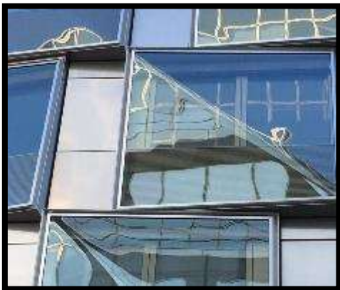
Figure 115 Facade double peau Bâtiment de bureaux cristallin
