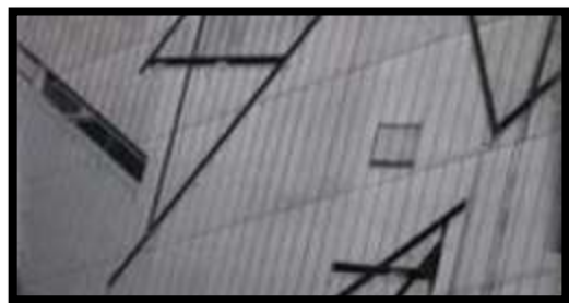
Figure 231 mur en granit
