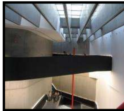
Figure 199 structure du toit partiellement vitré
