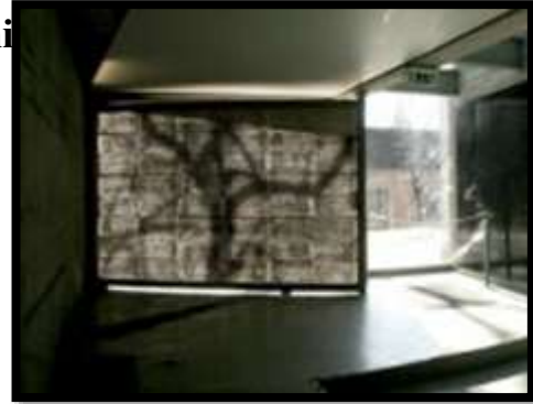
Figure 119 Litracon permet à la lumière naturelle de traverser des zones
