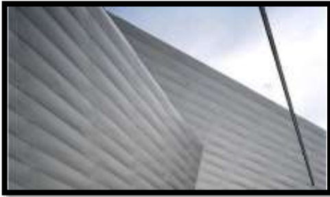
Figure 232 mur en titan
