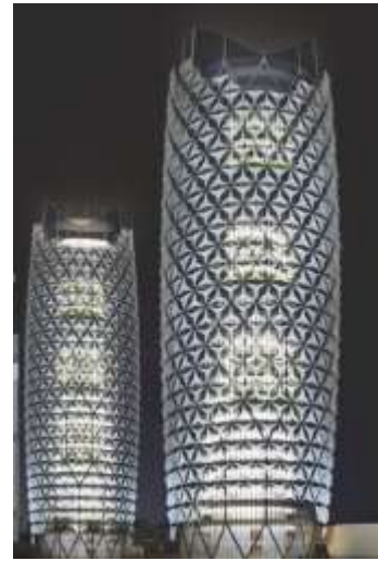
Figure 78 Façade réactive des tours Al Bahar
