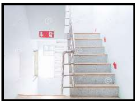
Figure 369 Escalier de secours
