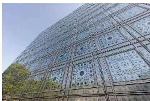
Figure 83 Institut du Monde Arabe IMA, Paris, France – Façade Sud
