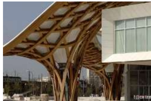
Figure 12 appuis en lamellé collé Centre Pompidou Metz
