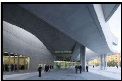
Figure 201 Plancher en béton auto-compactant
