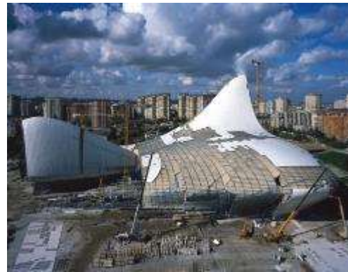
Figure 22 la peau du projet en réalisation Heydar Aliyev Center
