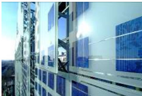
Figure 98 greenPix: détail d'un module photovoltaïque
