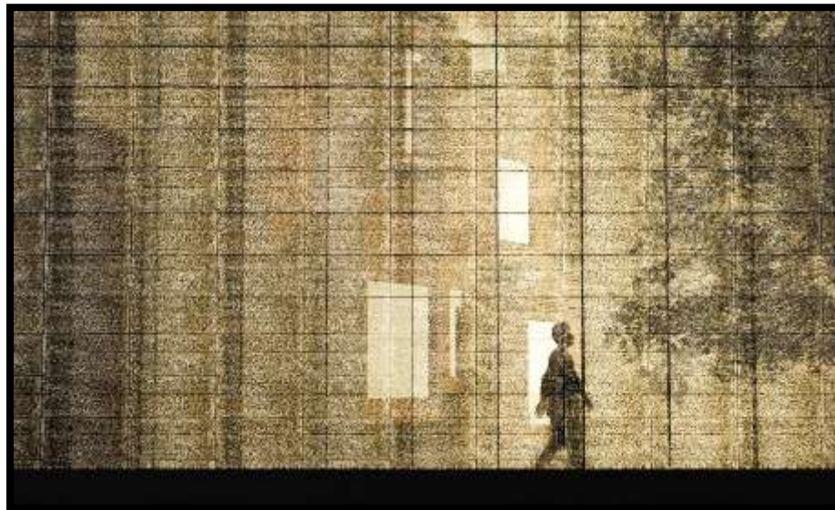
Figure 105 façade en béton translucide
