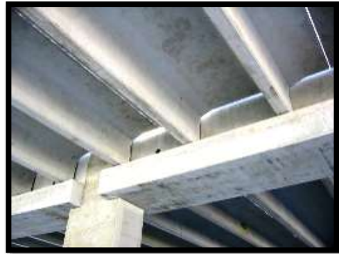
Figure 285 planchers nervuré pour parking
