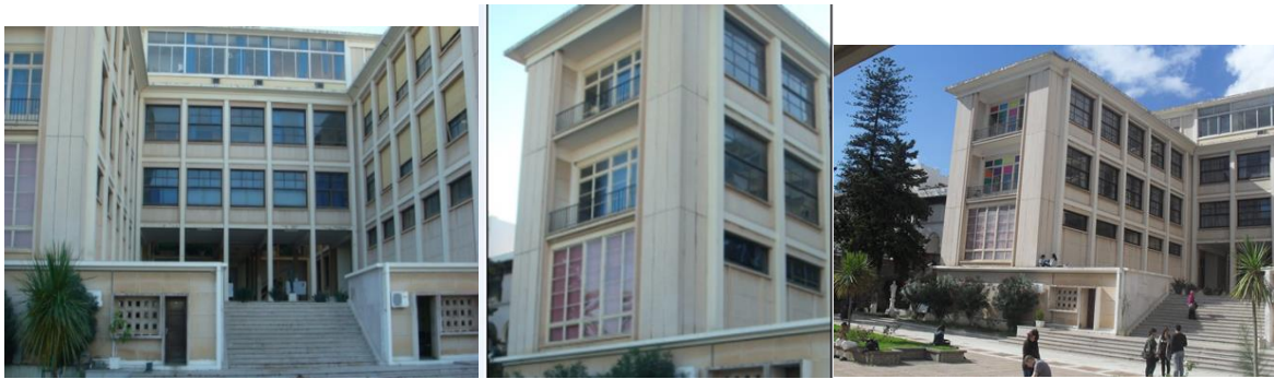
Figure 21 : façades de l'école
