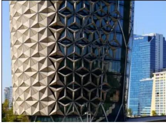
Figure 83 : façade adaptative des tours jumelles el bahr source : Al Bahar Towers, Abu Dhabi, Emirats Arabes Unis Image stock éditorial - Image du haut, architecture: 54322829
