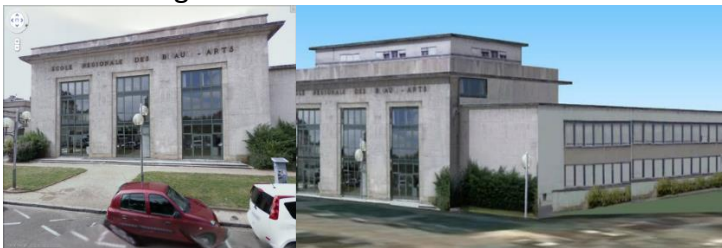
Figure 32 : façades de l'école
