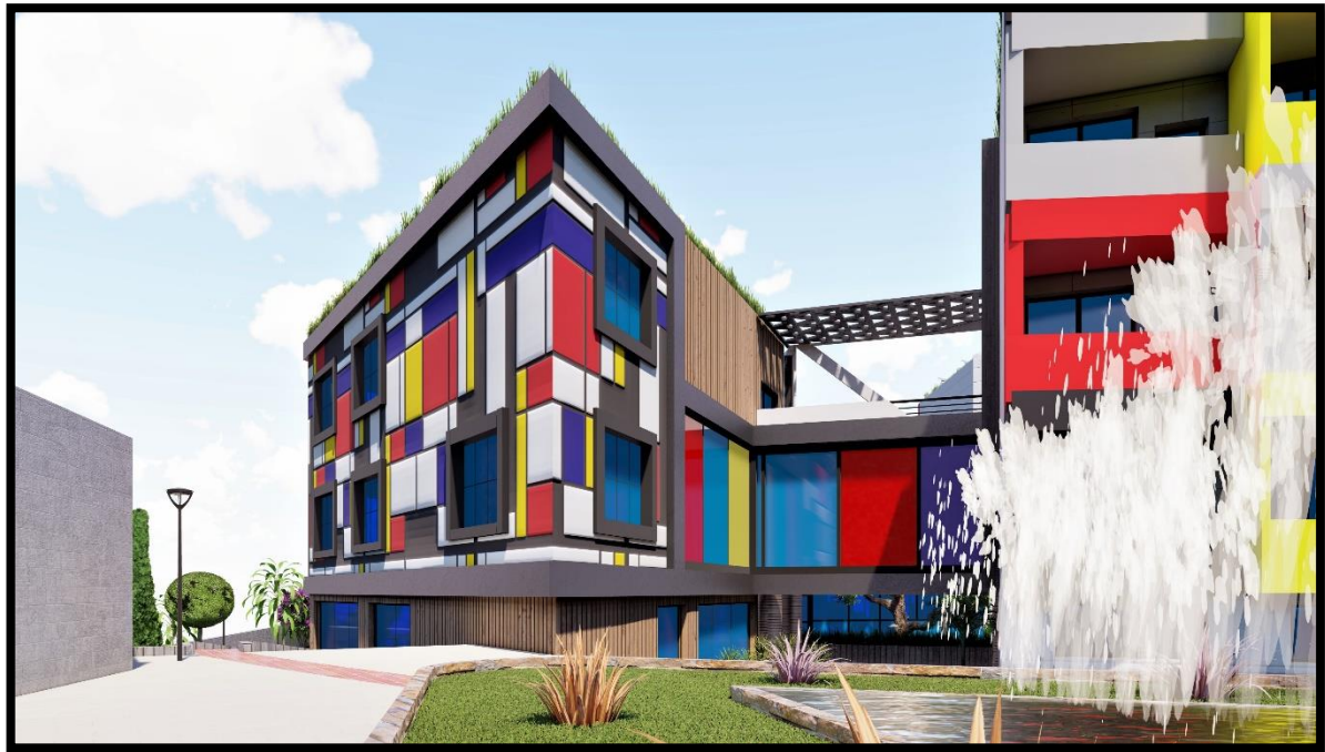
Figure 75 : Traitement de façade en panneau de céramique ventilé et bardage en bois
