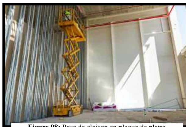
Figure 98: Pose de cloison en plaque de plâtre
