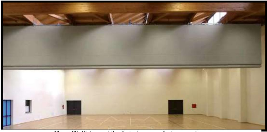
Figure 99: Cloison mobile pliante dans une salle de gymnastique
