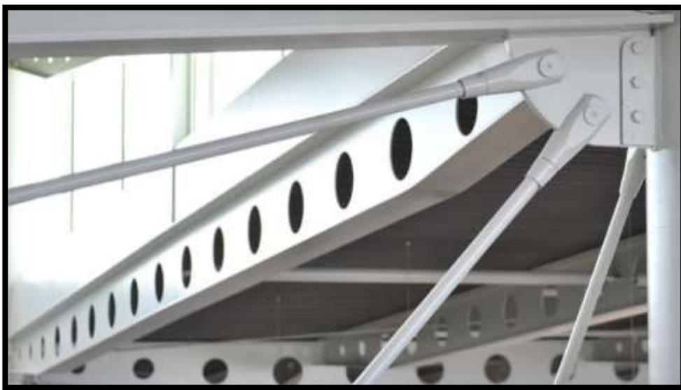
Figure 86: Poutre alvéolaire
