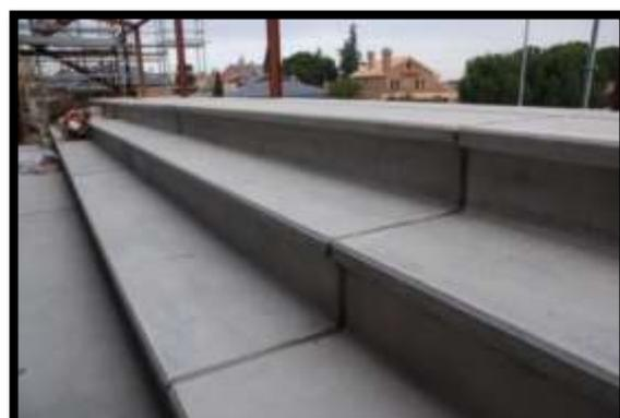
Figure 88: Gradin préfabriqué
