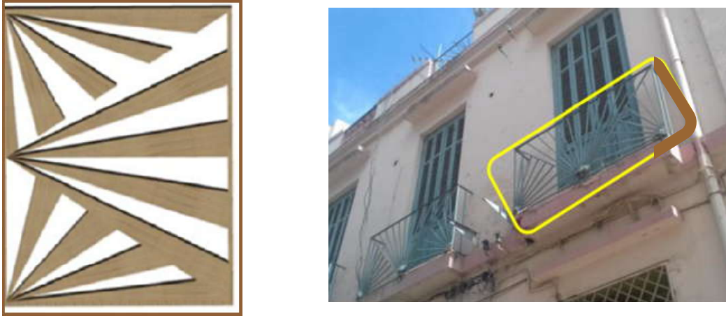
Figure 73: élément existant sur site
