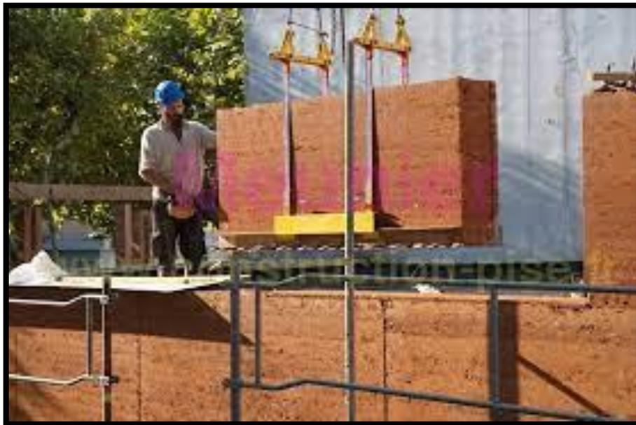
**Figure 67** : Mise en place du pisé préfabriqué
