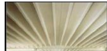
Figure 27: Exemple de plancher nervuré double T.
