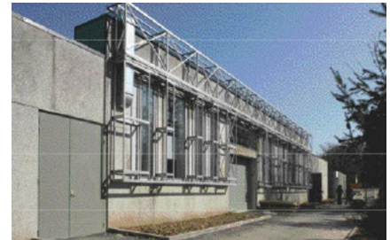
Figure 1: Préfabrication légère Des panneaux manutentionnés rhabillent un lycée Source: https://www.lemoniteur.fr/article/prefabrication-legere-des-panneaux-manutentionnes-rhabillent-un-lycee.904239
