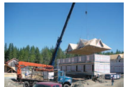
Figure 31: section de toiture
