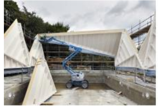
Figure 34: Montage des panneaux à ossature formant la coque plissée qui recouvre la piscine d'après (hobhouse, 2015) Source : www.apawood.org .
