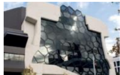
Figure 36: Revêtement de façade en GRC Source : M.K. une solution de construction pour architectes et ingénieurs.pdf.
