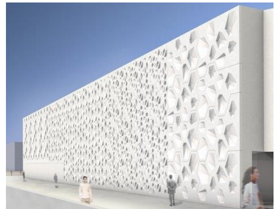
Figure 35: façade en GRC
