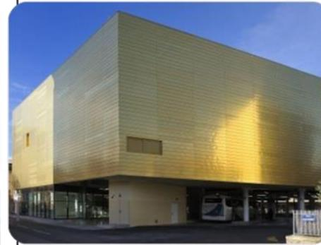
Système constructif poteau-poutre en béton armé avec de niveau de sous-sol et RDC+2
