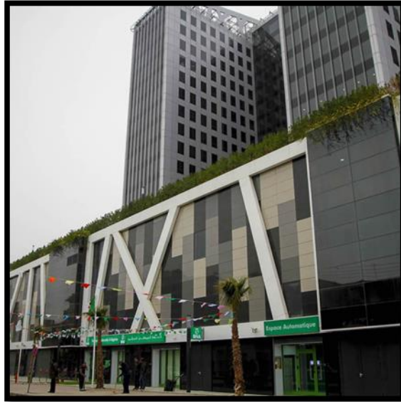
Figure 3: PArk Mall Sétif (source: http://www.arte-charpentier.com/fr/projet/complexe-park-mall/ )
