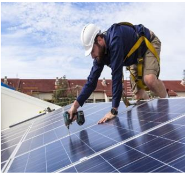
Figure 8: entretien des panneaux photovoltaïques.
