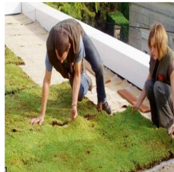
Figure 7: L'entretien d'un toit végétalisé.
