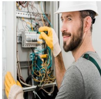
Figure 9: la maintenance électrique.
