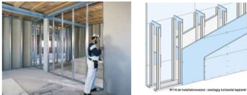
Figure 113: cloison à ossature métallique
