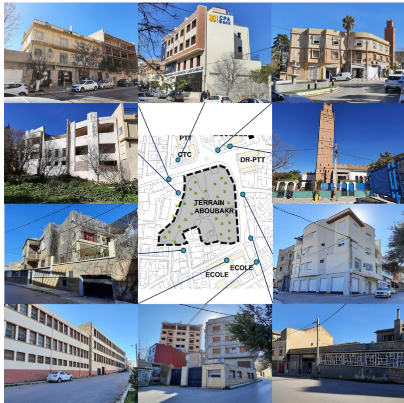
Figure 31 Photos des façades environnantes situées sur la carte du PDAU (Source : prise de photos par l'auteur le 16/02/2021)
