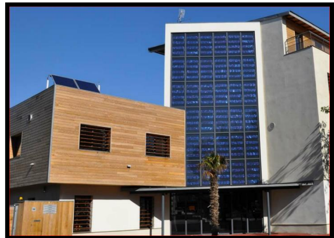
Fig 106 exemple de mur rideau en panneaux photovoltaïques
