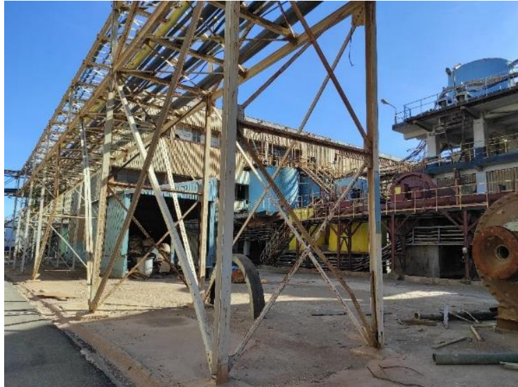
Figure 53 : Photo montrant les ouvertures source d'inspiration pour les ouvertures du hangar ainsi que les couleurs utilisés pour les différentes phases de production
