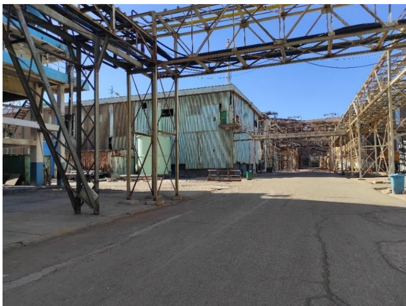
Figure 56 : Photo des structures métalliques suspendues au niveau de l'usine ALZINC
