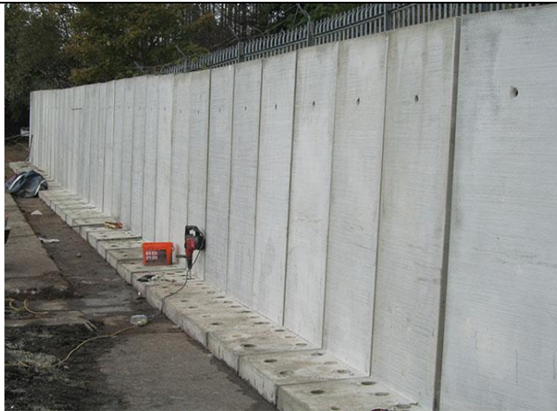
Figure 45 : Mur voile préfabriqué
