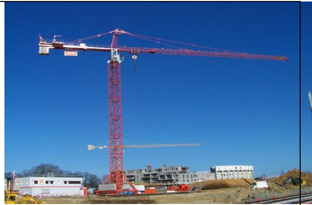
Figure 19 : Grue à tour
