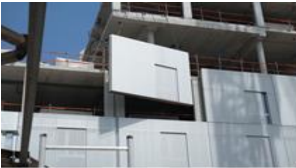
Figure 10 : Panneaux de façade préfabriqués
