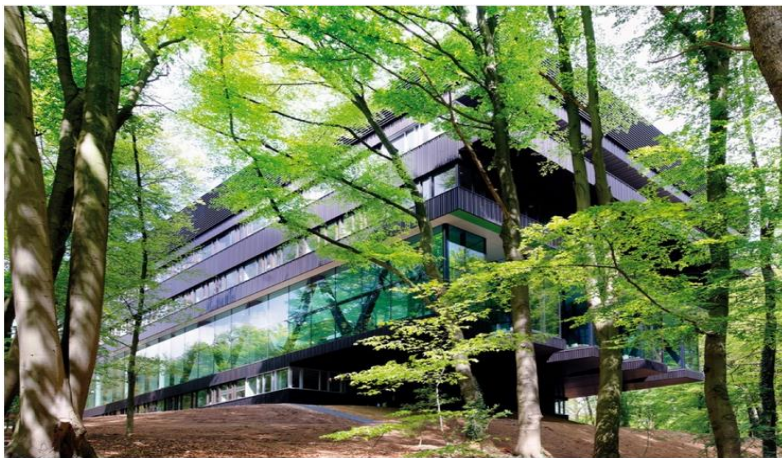
Figure 63 : Façade principale exemple 1
