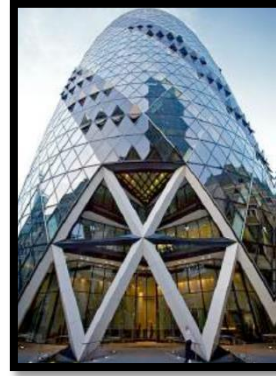
Figure 52 : les six puits de lumière.
