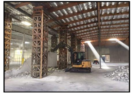
Figure 13 : Bâtiment d'origine Entrepôt de vin Source : Google photo
