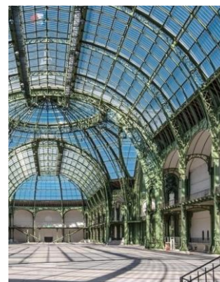
Figure 132 : structure métallique Source Google photo
