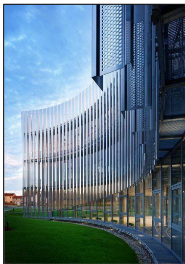
Figure 146 : facade en panneaux métallique
