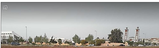
Figure 80 : façade nord-est (source l'auteur)
