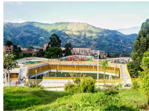
Figure 40 : façade d'UVA sur terrain
