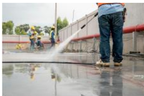
Figure 138 : laver le sol des engins Source : Google images
