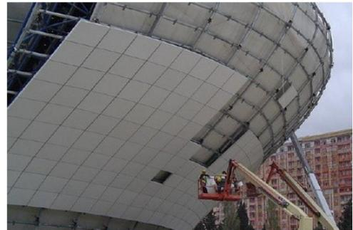
**Figure 117:**Éléments de revêtement à GFRP
