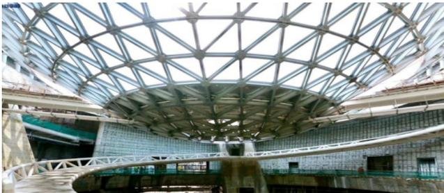
Figure 13 :la couverture de gridshell
