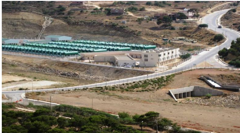
Figure 3.8.1 : Photo de la station de dessalement de Honaine
