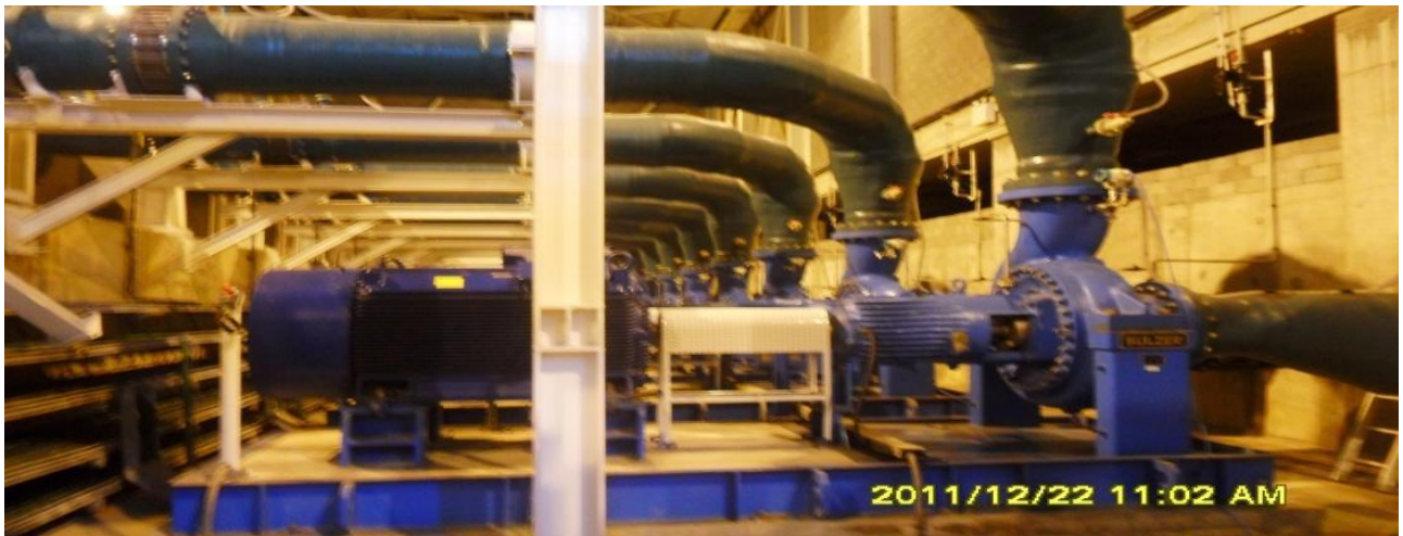
Figure 3.2.5 : Photo du bloc de pompes de captation 14
