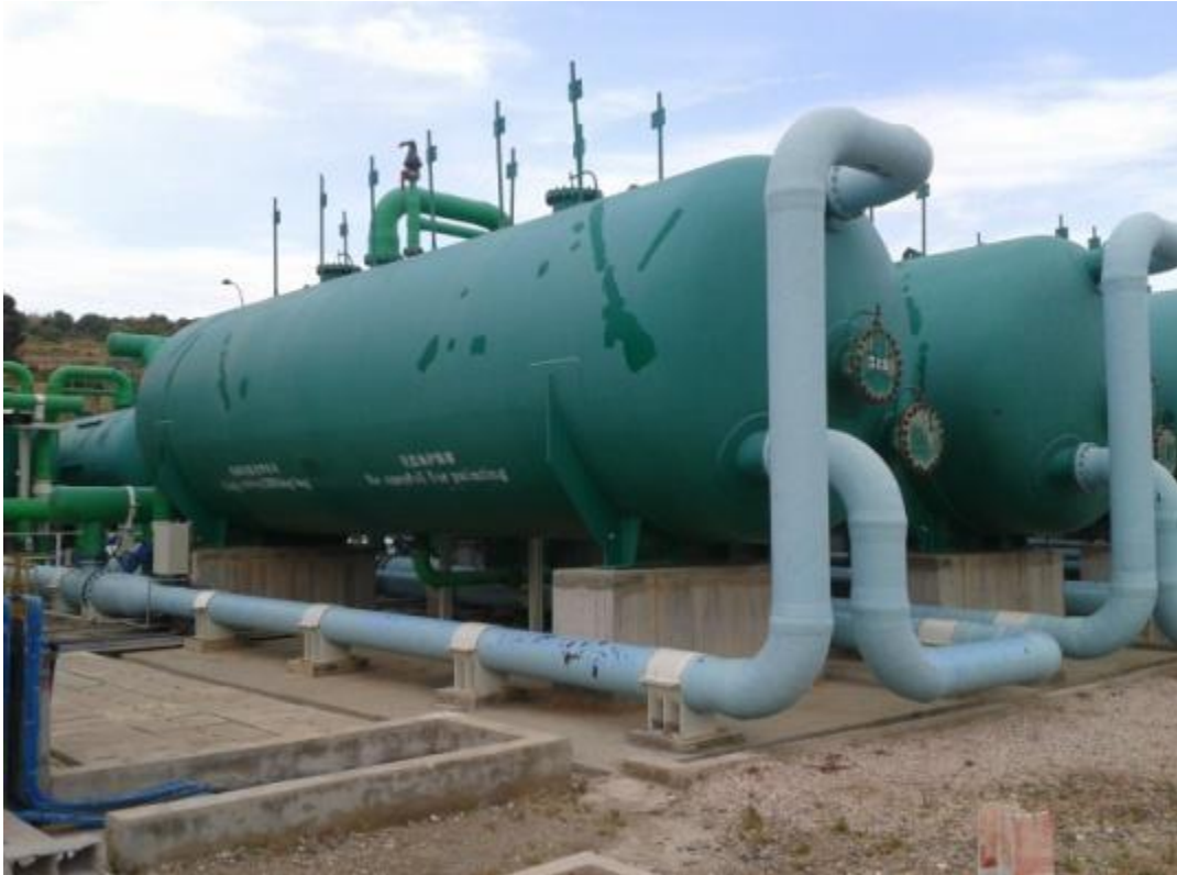
Figure 3.8.10 : filtres à sables et anthracite (Station de dessalement-Honaïne)
