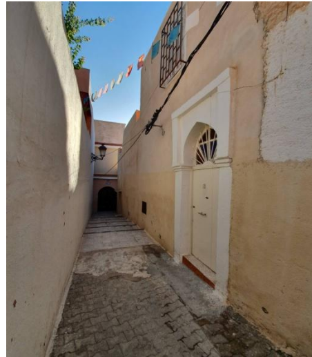
Figure 68: maison en bon état auteur2020
