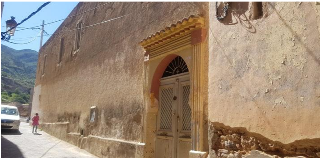
Figure 36: maison traditionnel en r+1 dar rahal Source : auteur
