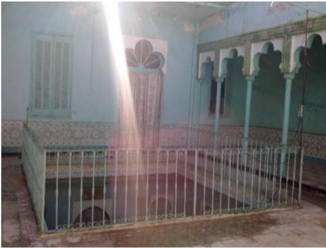
Figure 67: dar senhadji avec patio auteur2020
