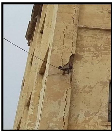
Figure 32 101 , Figure33 102 . Le phénomène de fissuration de béton.
