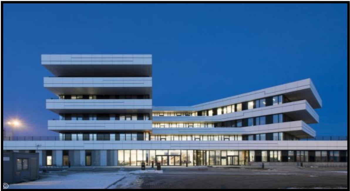
Figure84. Vue d'exterieure du projet port center. 164
