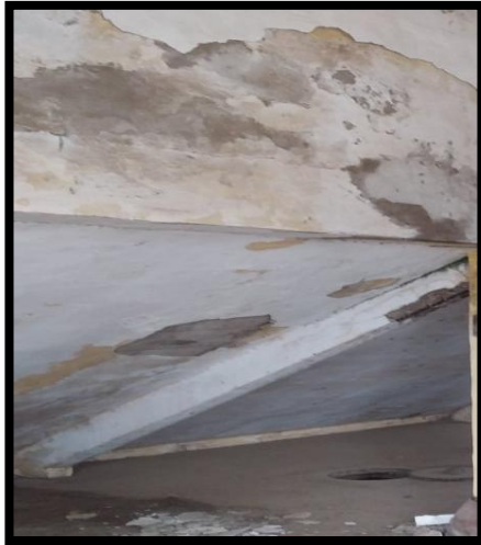
Figure34 103 , Figure35 104 . Le phénomène deségrégation de béton.
