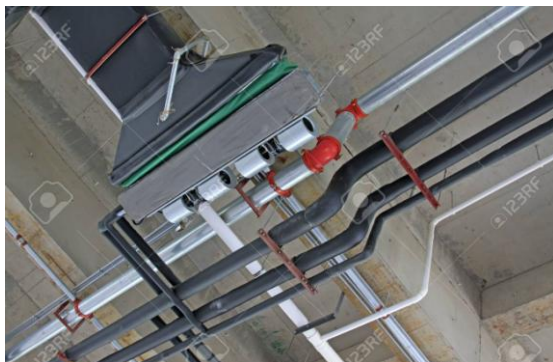
Figure79. Les composantes d'un système air/air. 156
