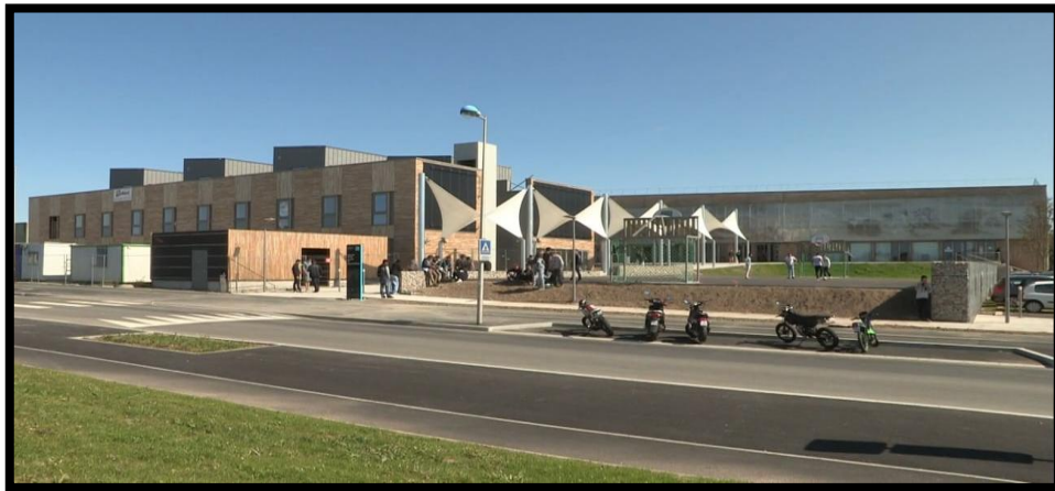
Figure 47. Vue d'extérieur sur le projet. 118
