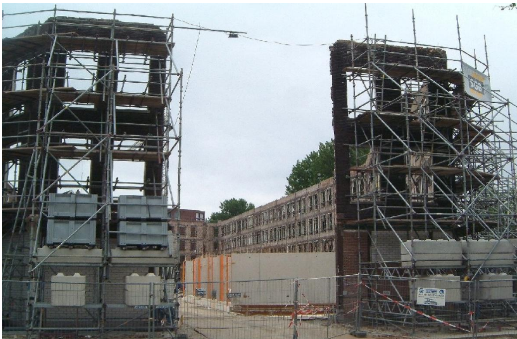
Figure 4. Présentation d'une façade du 19 ème siècle, Noorderiland, 2007. 42
