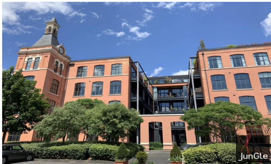
Figure 11. La filature à Rouen vue d'extérieur. 54
