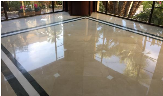
Figure74. Dallage en marbre. 149
