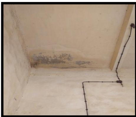
Figure36 105 , Figure37 106 . Le phénomène de remontée d'humidité par capillarité.
