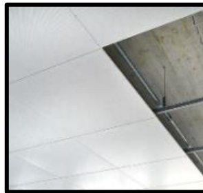
Figure 152. Exemple de faux plafonds suspendu.
