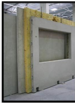
Figure 149. Exemple d'un panneau sandwich en béton. 56
