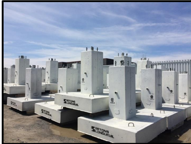
Figure 52. Exemple fondations isolés préfabriquées. 41
