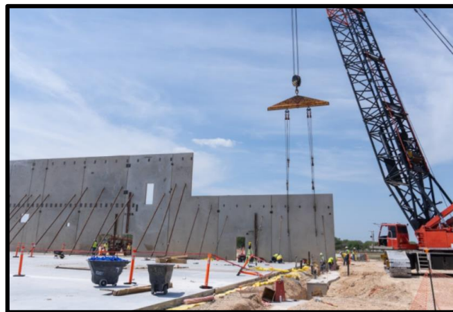
Figure 65. Disposition de panneaux préfabriqués. Source : innovation center page officiel web site
