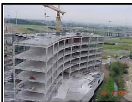
Figure 13. Exemple d'une ossature préfabriquée bâtiments élevés. 19
