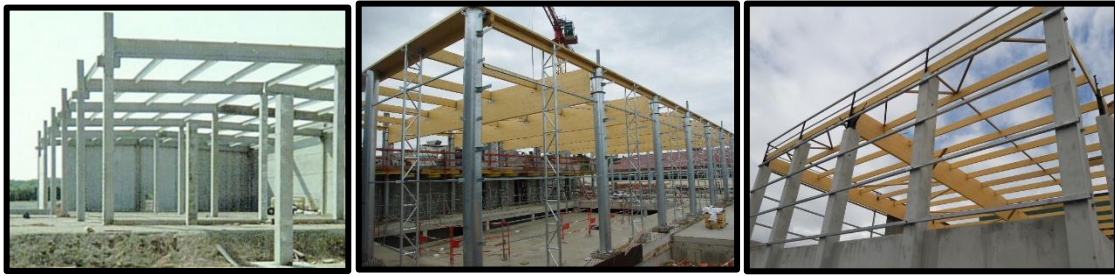
Figure 10. Exemples des portiques mixtes. 16
