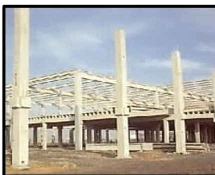
Figure 12. Exemple d'une construction par ossature préfabriquée bas. 19
