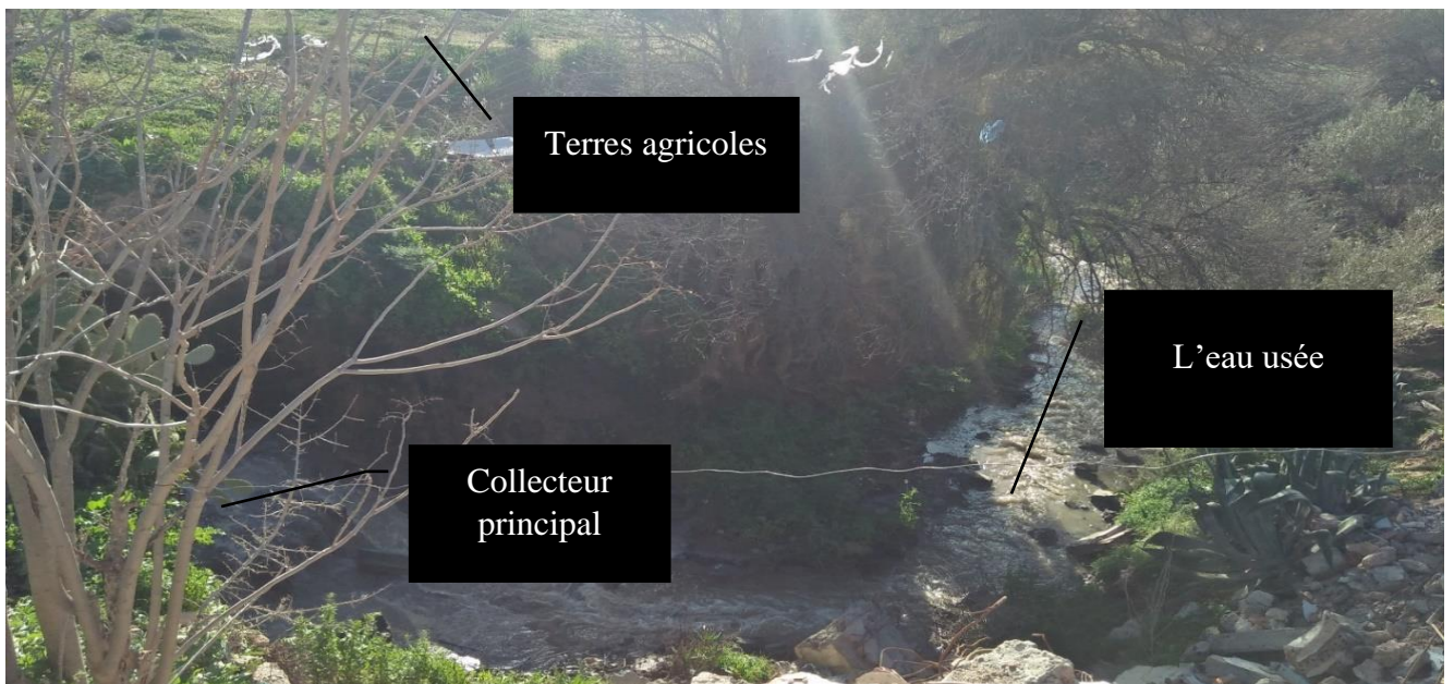
Figure 35 : Photo représentant le collecteur principal de la STEP (Chater&Bendjeffal,2020)
