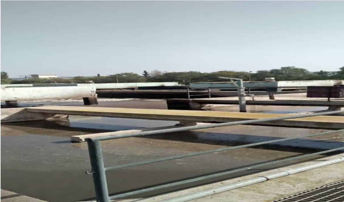
Figure 46 : Bassin d'aération (4unités). (Chater& Bendjefal, 2020)
