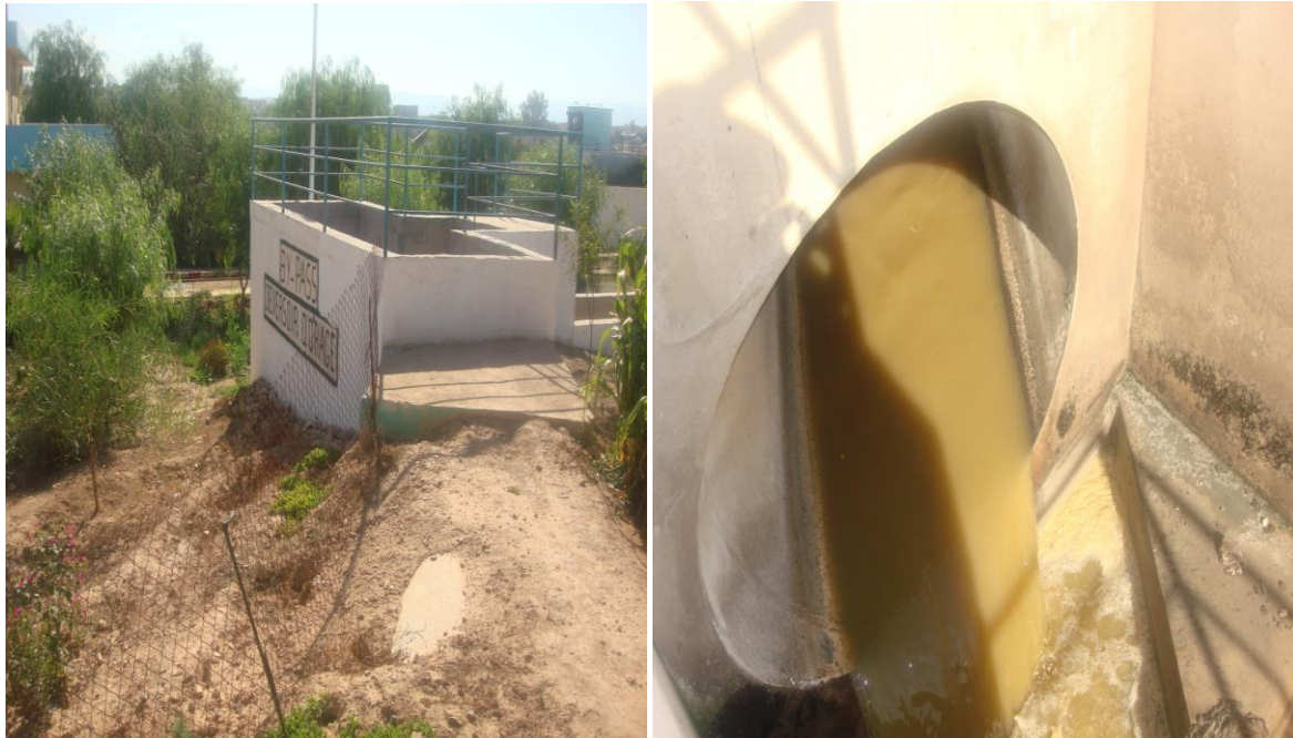
Figure 42 : Le déversoir d’orage. (La D.R.E de la wilaya de Tlemcen et la Zone d’Oran (ONA2003).
