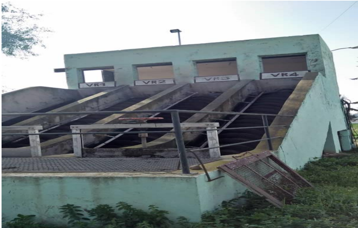
Figure 43 : Bâtiment de relevage. (Chater& Bendjeffal, 2020).
