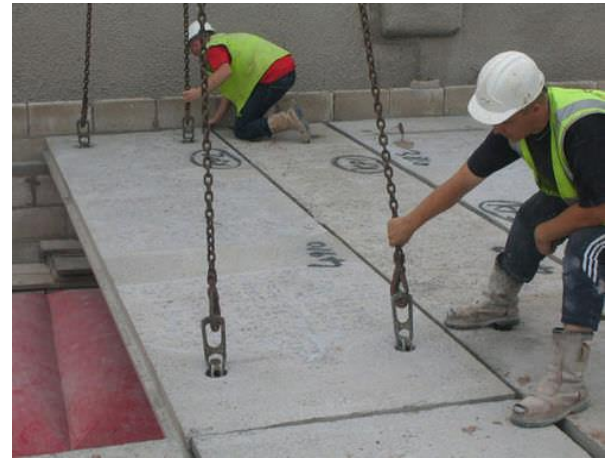
Figure 1.4 : Plancher préfabriqué en béton armé
