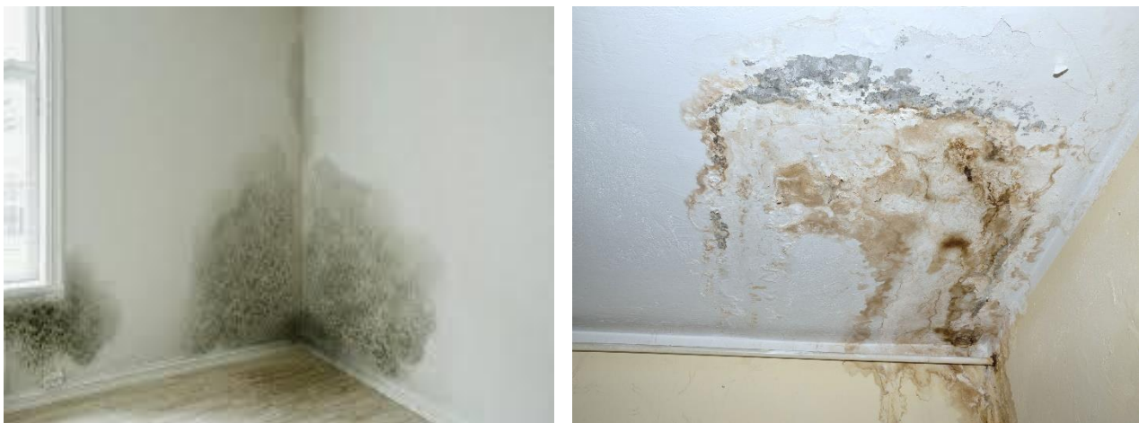
Figure 1.11 : Traces d'humidité
