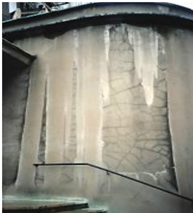
Figure 1.23 : Faïençage lié à une attaque sulfatique
