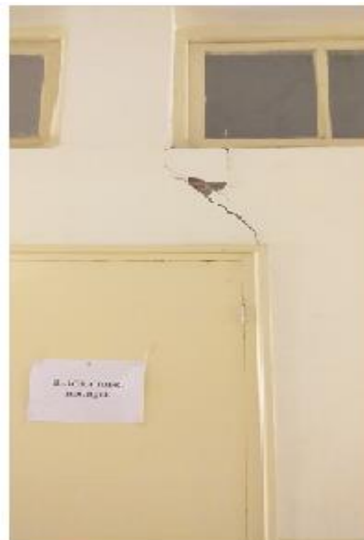
Figure 3.19 : Fissure lézarde au niveau du joint de dilatation de la salle 16
