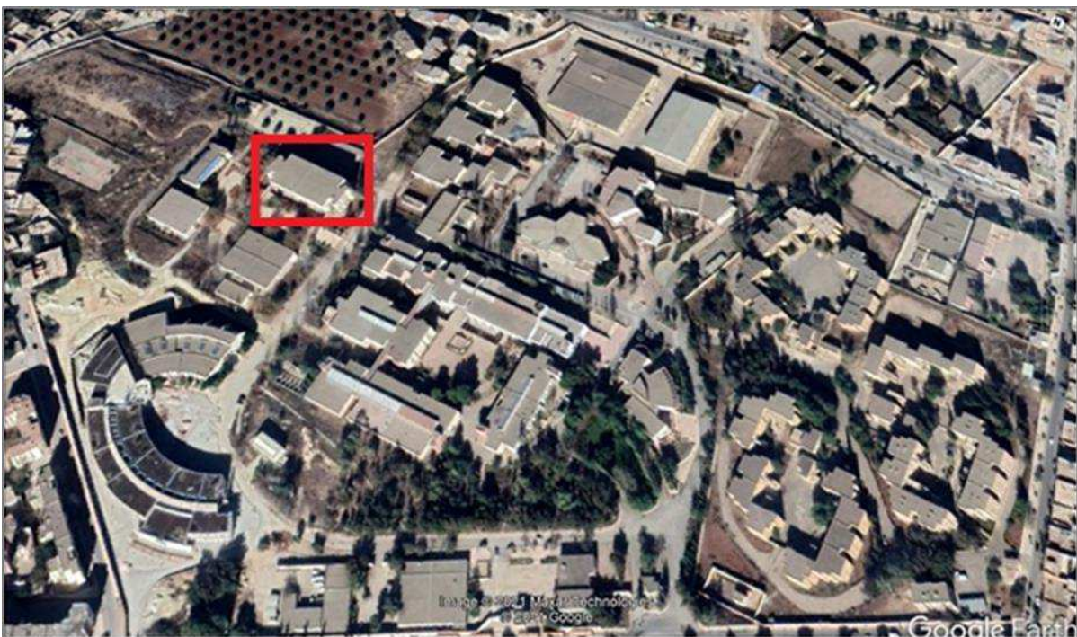
Figure 2.11 : Vue aérienne du bloc de génie biomédical réalisé dans la période après l'année 2000
