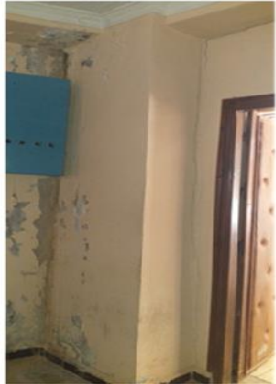
Figure 3.4 : Traces d'humidité sur le mur du grand amphi G2
