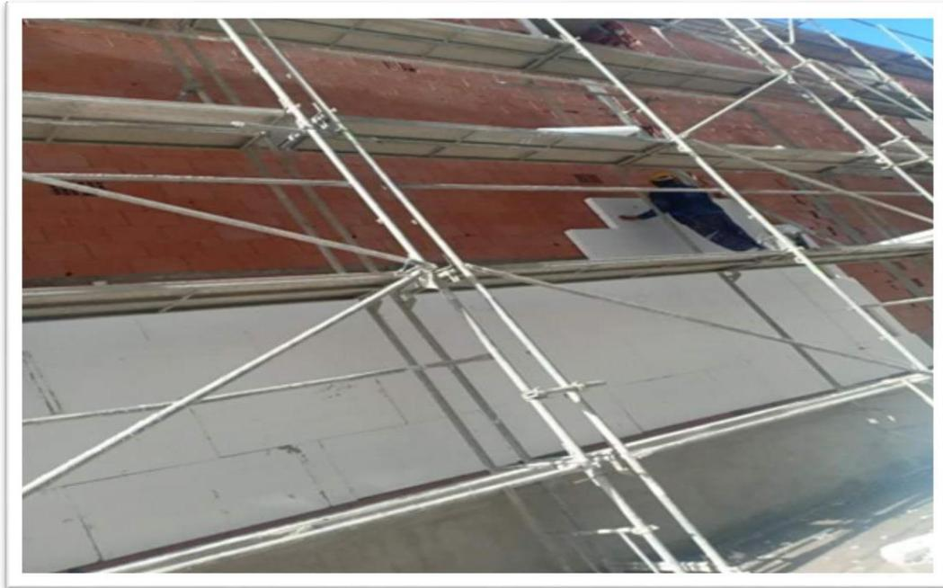
**Figure II.7 :** Exemple sur l'isolation par extérieur
