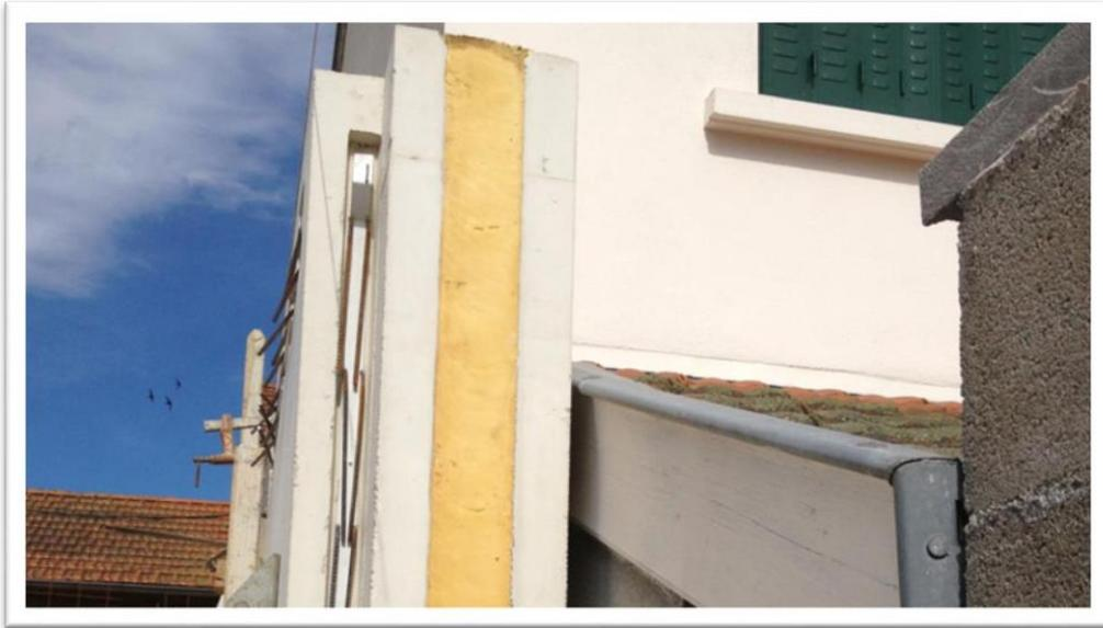
**Figure II.6 :** Exemple sur l'isolation intégrée
