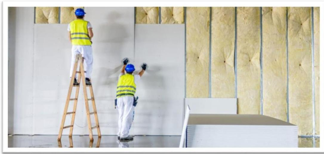
**Figure II.5 :** Exemple sur l'isolation par intérieur
