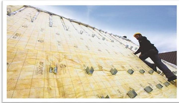
**Figure II.8 :** Exemple sur l'isolation sur toiture
