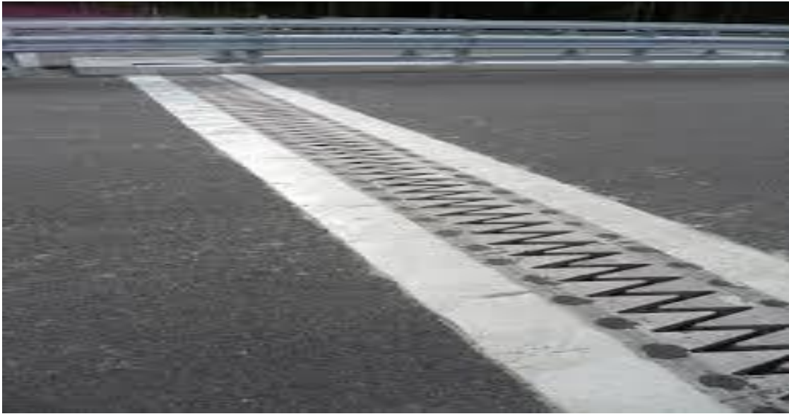
Figure 6.3 : Joint de chaussée
