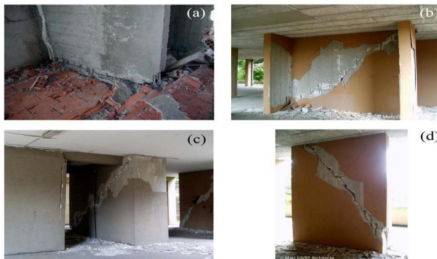
Figure 1.9 Modes de rupture des voiles élancés (1)
