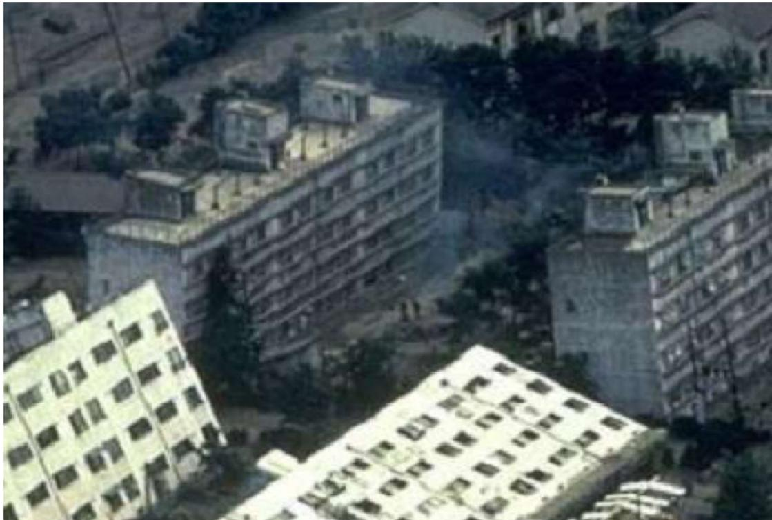
**Figure I.2 :** Inclinaison des bâtiments d'appartements de Kawagishi-cho à Niigata au Japon dues à la chute de la capacité portante du sol par liquéfaction ( Peter M. Byrne et al, 2008).
