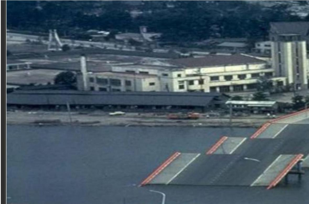
**Figure I.3** : Rupture du pont de Showa, à Niigata au Japon, dues à l'épandage latéral dans le sol (d'après Peter M. Byrne et al., 2008)
