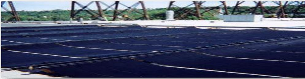
Figure 1.14: Capteurs solaires sans vitrage (capteur moquette)
