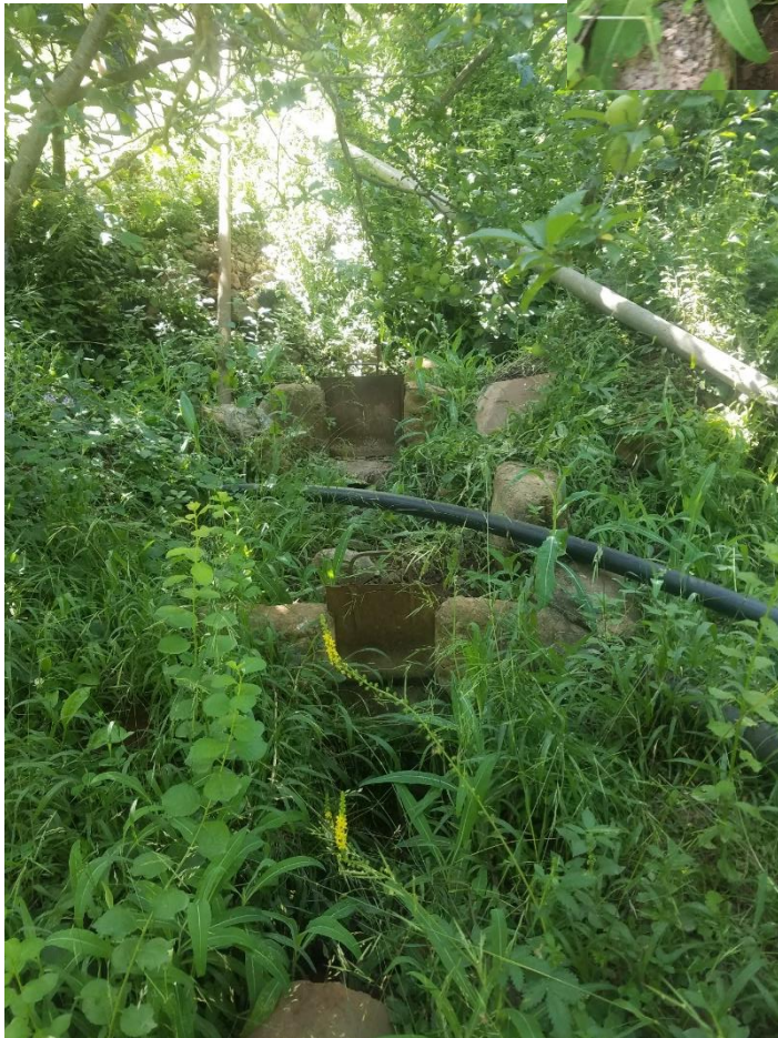
Figure 52 : Petit bassin utilisé pour l'irrigation [P1].
