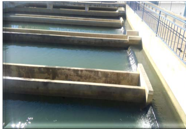
Photos 22 : les bassins de filtration
