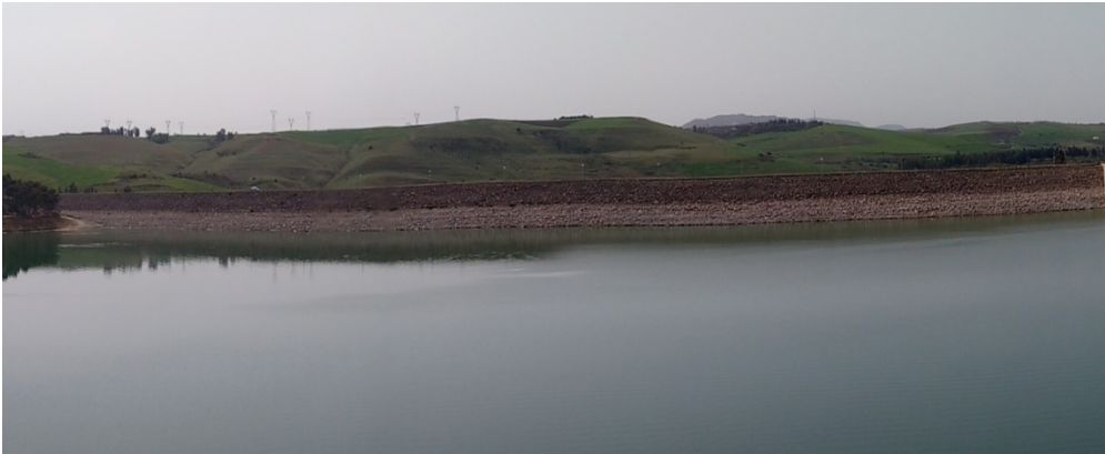
Photos 02 : La digue du barrage El Izdihar (coté interne)
