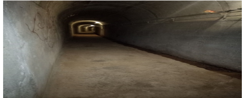
Photos 03 : la galerie du barrage
