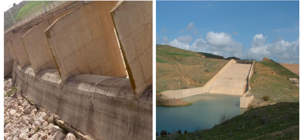
Photos 05 : L'évacuateur de crue avec le bassin d'amortissement du barrage
