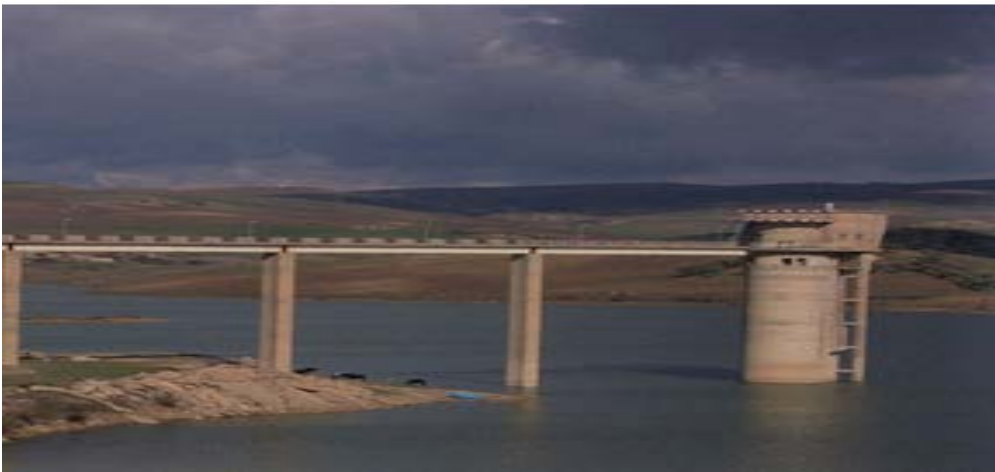
Photos 04 : La tour de prise d'eau du barrage
