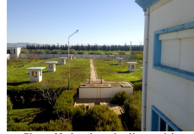
Photos 23 : les réservoirs d'eau traitée
