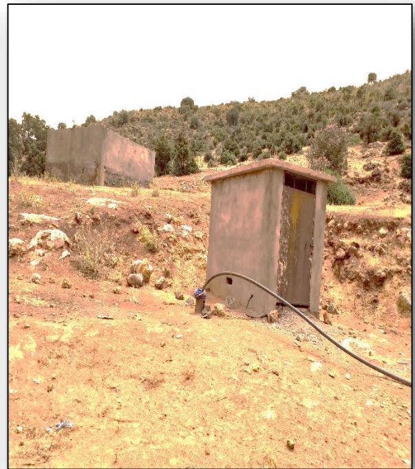
Photo 2 : Réalisation de forage
