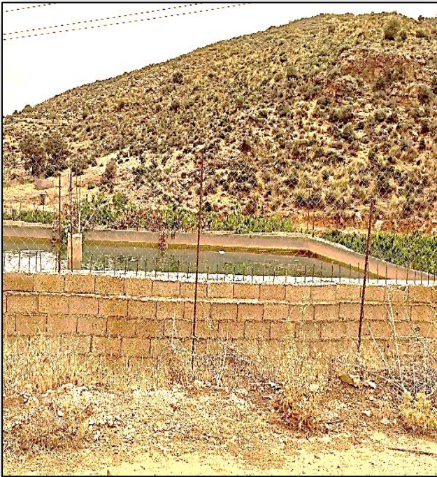
Photo 1 : Construction de bassin
