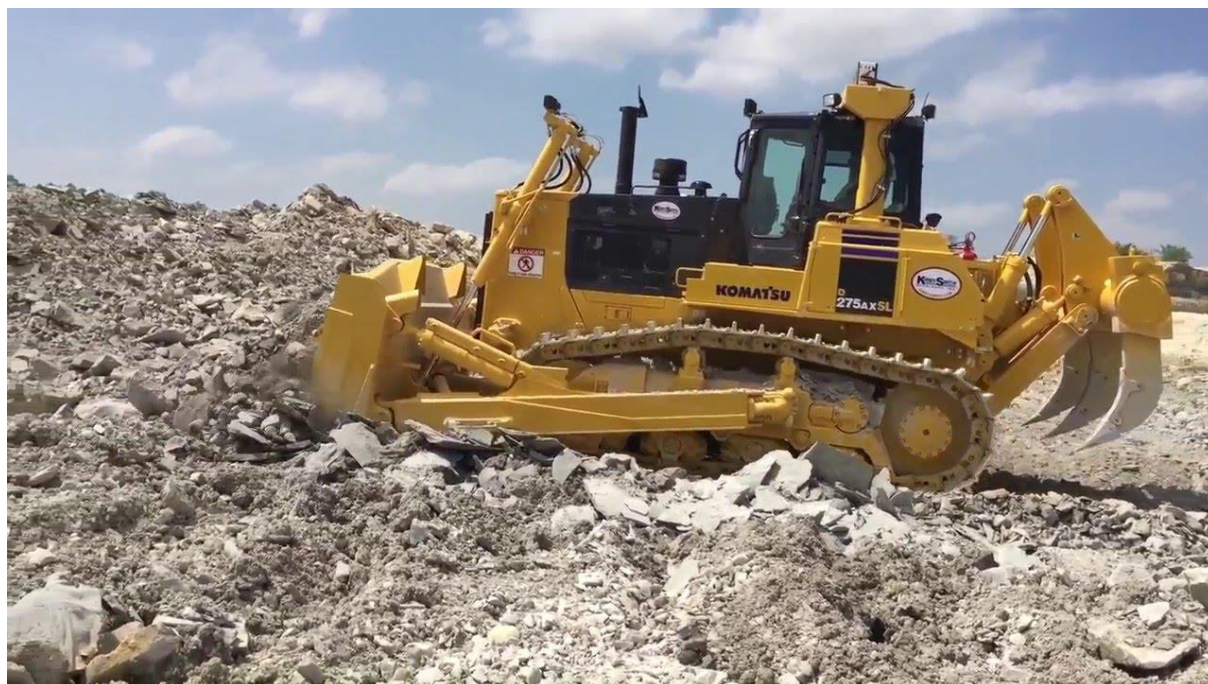
Figure 8 : Bulldozer de type Komatsu utilisé dans les travaux de découverte.
