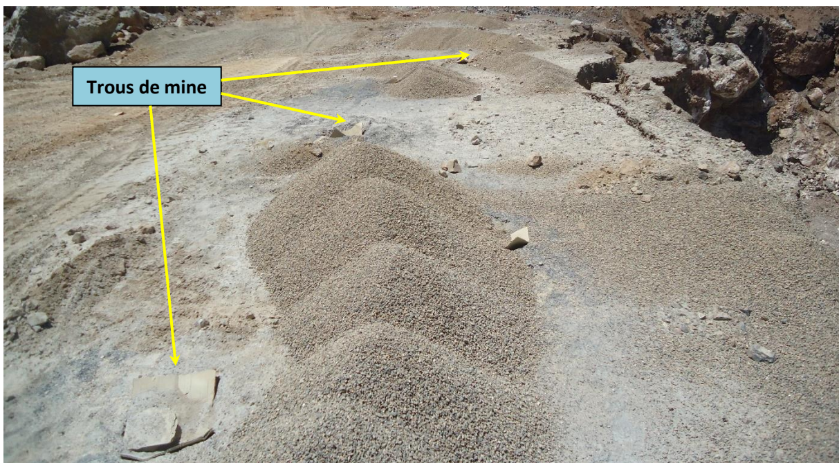
Figure 10 : Trous de mine pour un prochain tir de mine
