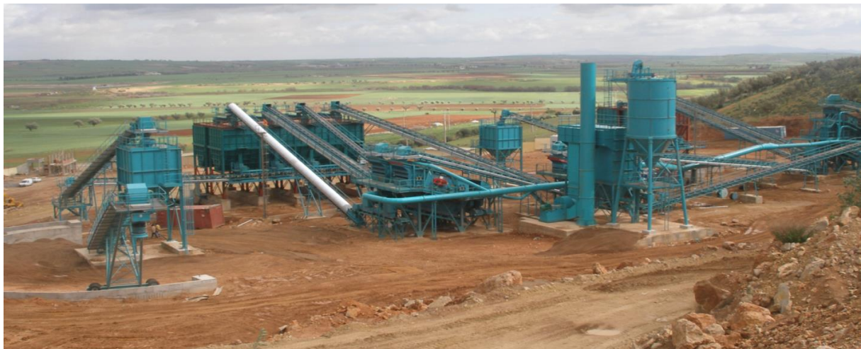
Figure 16 : La station de concassage sise à l'unité de l'ENG d'El Maleh
